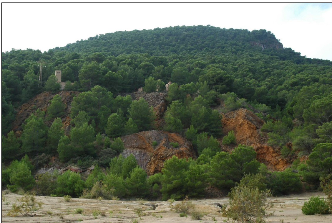
Foto 7. Ladera de la Peña del Águila y restos de construcciones y escombreras de la mina Secretaría, una de las muchas que se encuentran en todo el Parque.
